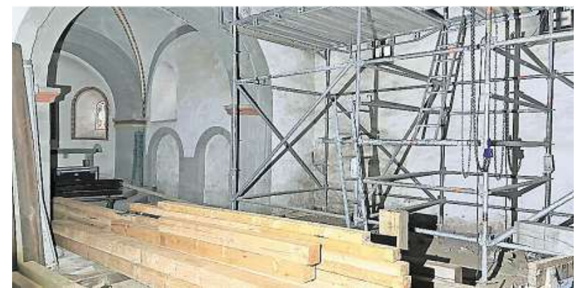
Besonders langlebige Holzbalken aus Eiche oder Douglasie werden im denkmalgeschützten Gebäude eingesetzt.
