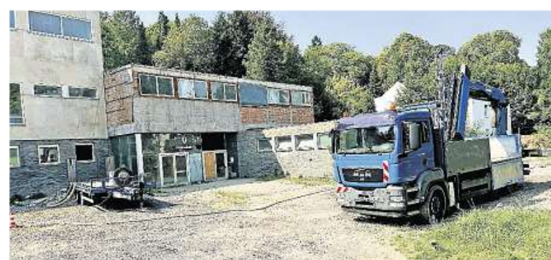
Das leerstehende Gebäude des Kurfürstenbades verfällt immer mehr. FOTO: AXEL VOGEL
