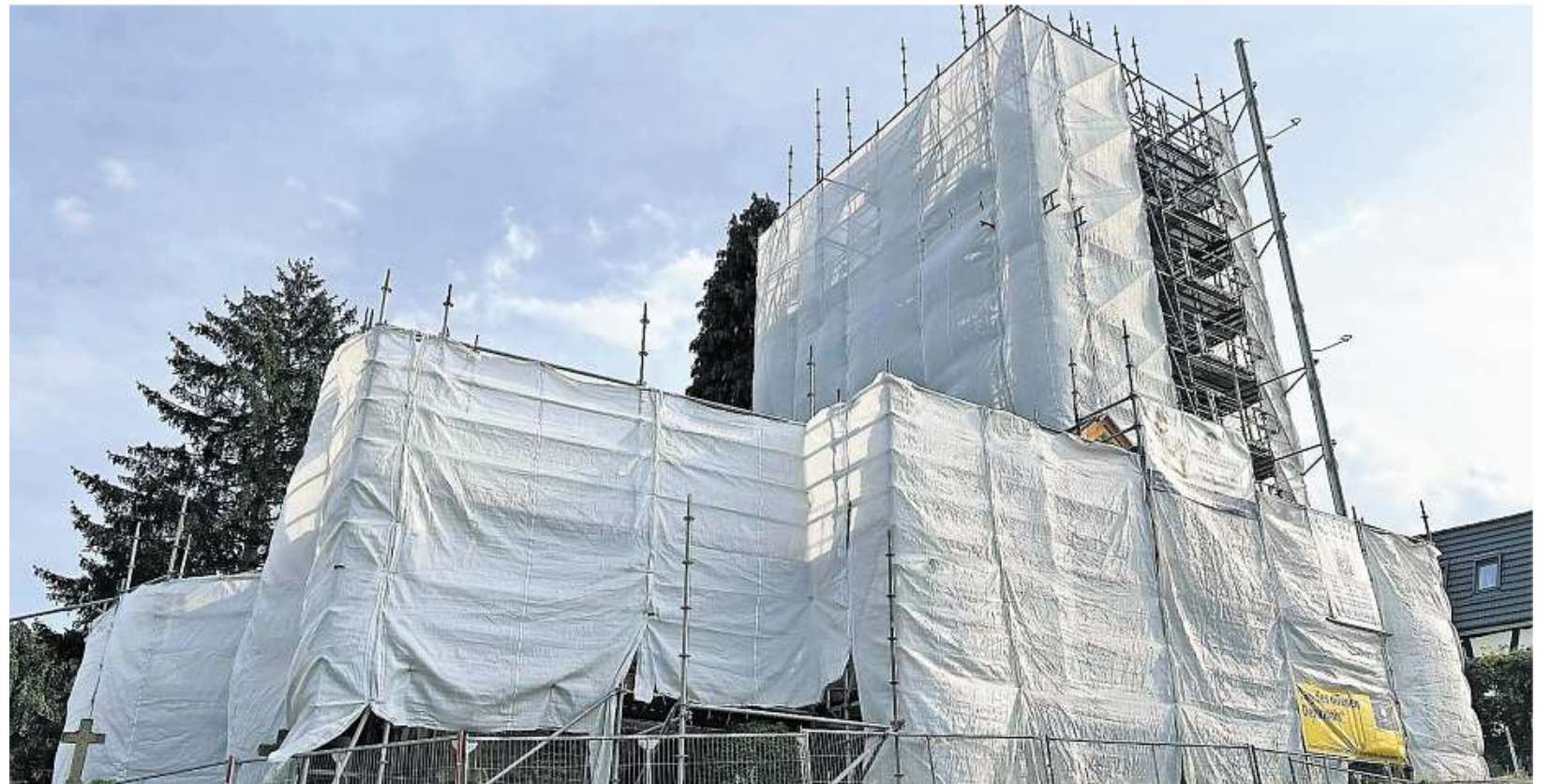
Die Kirche Alt Sankt Martin in Muffendorf verhüllt unter Bauplanen und Gerüsten. Die Sanierung ist im vollen Gange. FOTOS: ALESSANDRA FAHL
